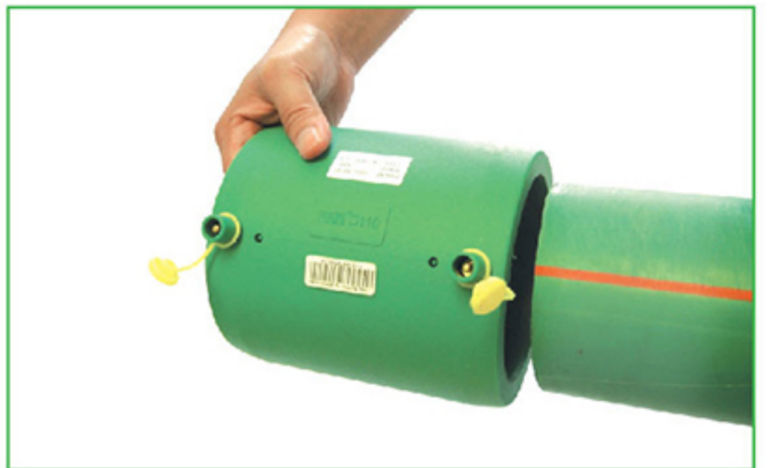
4 นำท่อสวมเข้ากับข้อต่อทั้งสองด้าน ดันจนถึงจุดมาร์ค
