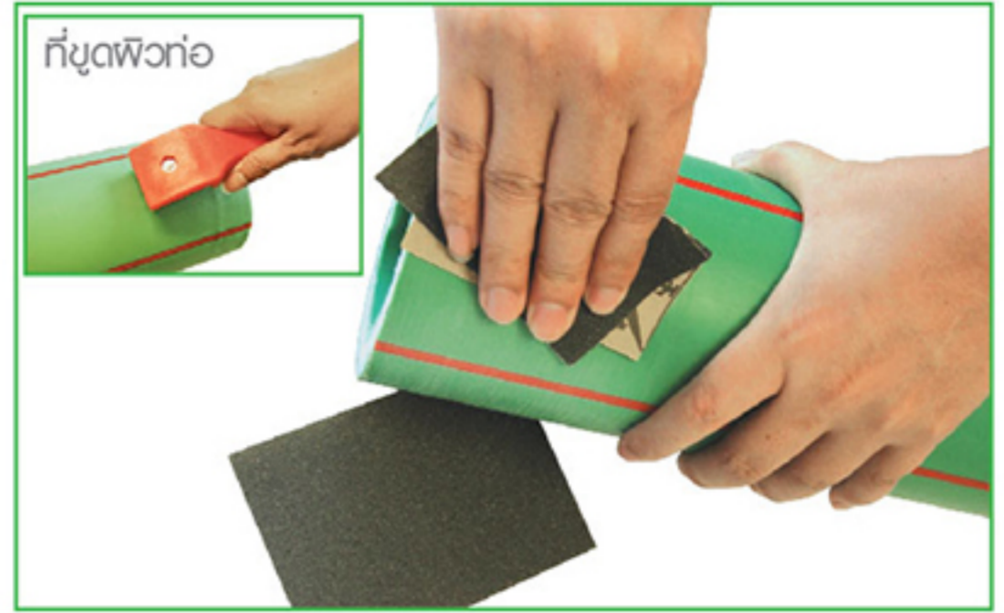
2 ขัดผิวท่อที่วัดระยะไว้ด้วยกระดาษทราย / ที่ขัดผิวท่อ
